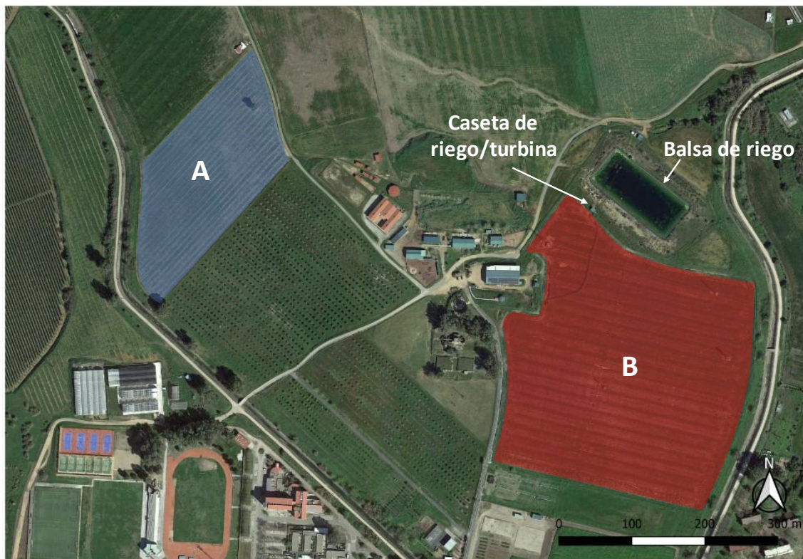
Figura 10. Instalación de riego sobre la que se encuentra instalada la turbina.
